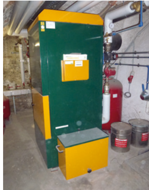
Pelletsheizung mit einer Leistung von 99 kW, Contractor: WDS Graz (Tochter Energie Graz)
